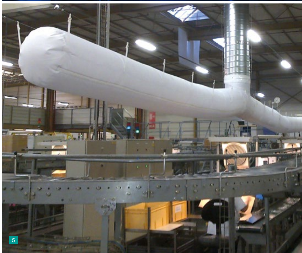
4 - Plenum de diffusion au sein d'un process 5 - Diffusion d'air rafraîchi par gaine textile
