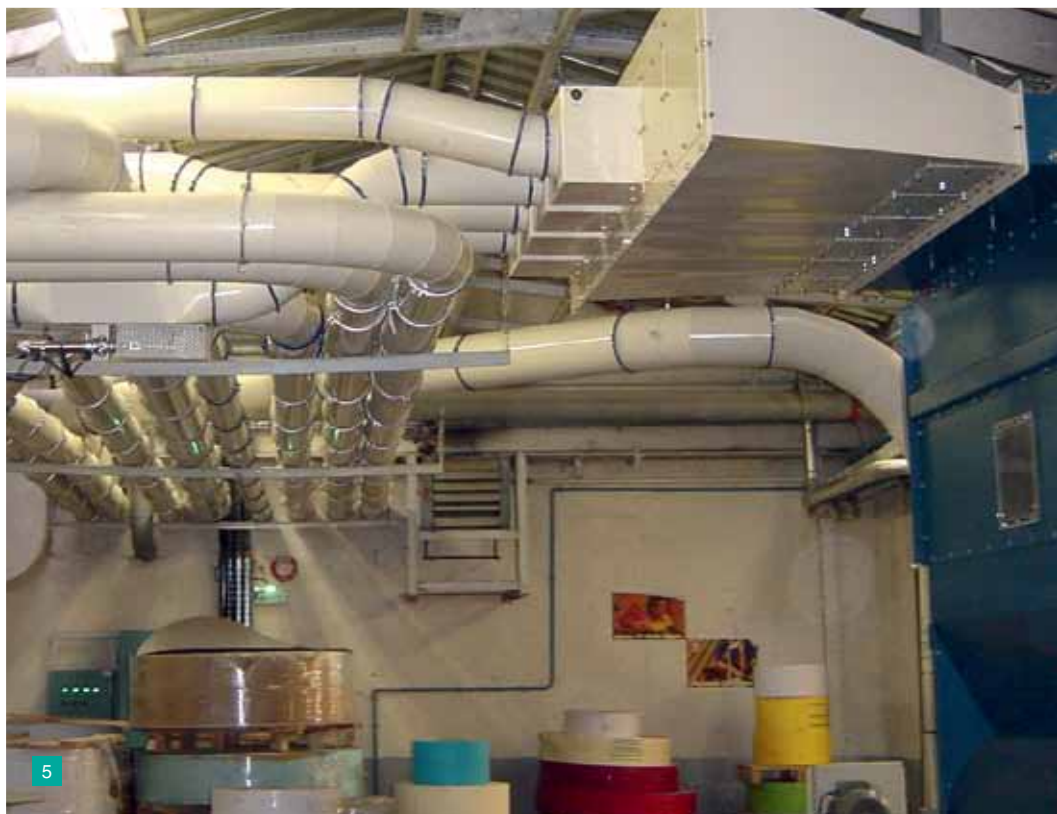
4 - Centre d'essais pour le transport pneumatique de déchets continus et discontinus 5 - Captage de déchets papier dans une imprimerie
