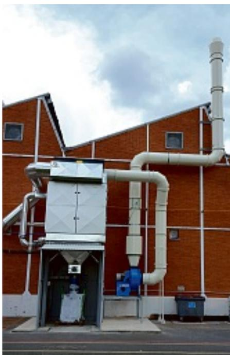
Le JETLINE K de DELTA NEU utilisé pour la protection des opérateurs.
