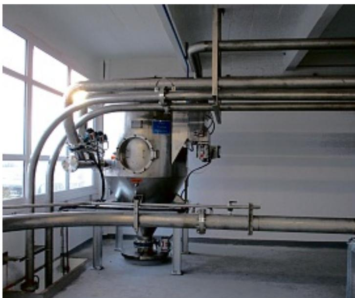
Process installé par NEU PROCESS pour la production de poudres lessivielles.
